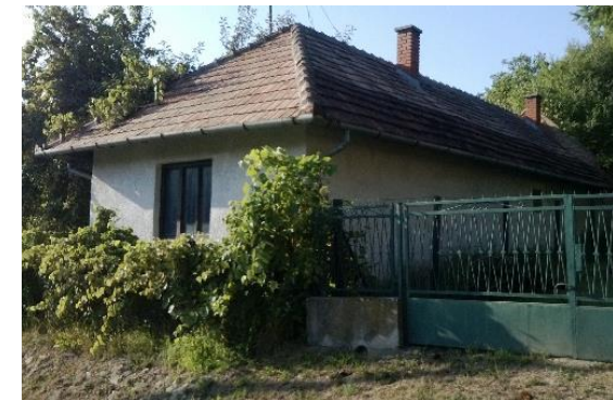
LAKÓ- ÉS MELLÉKÉPÜLET – RÁKÓCZI F. U. 65. - HJ
